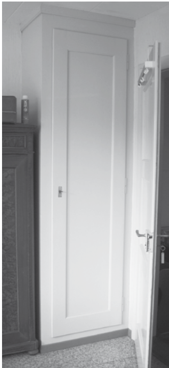
Einbauschränke aus Holz gestrichen
