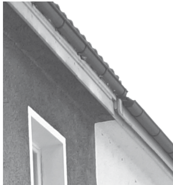
Originale Untersicht mit Wormserverputz (grobkörniger Putz)
