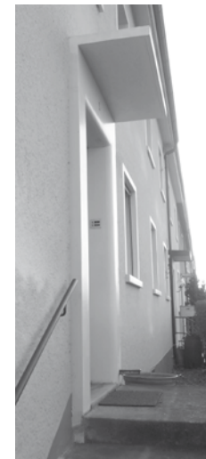
Originales Vordach, Breitfeldstrasse 2
