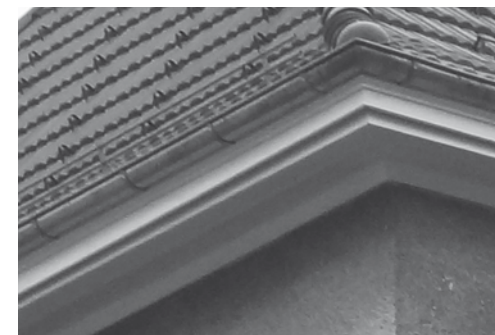
Dachrandabschluss, empfehlenswert Wiesenstrasse 66
